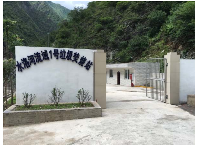
图(5) 一水洛河生活垃圾焚烧站一
