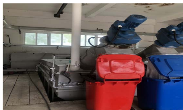
图1 粪便无害化处理系统中的固液分离设备
