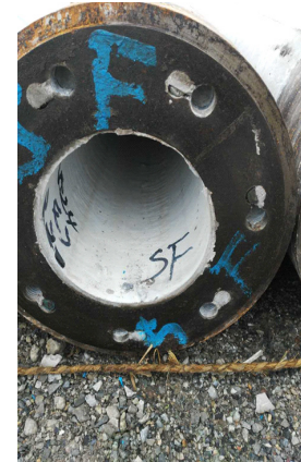
复合掺合料桩内壁
