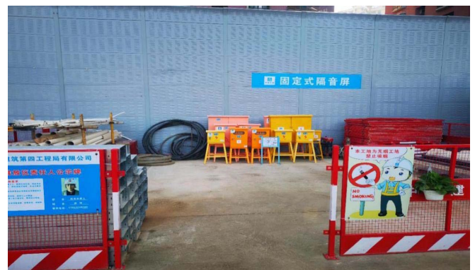
图3-1项目现场四周固定式隔音屏
