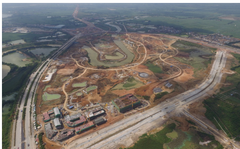
图三 园博园(建设中)航拍图
